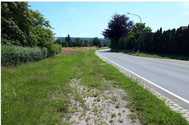
In einem ersten Schritt wurden die Bäume und Sträucher in der Trasse entfernt, da das Bundesnaturschutzgesetz eine Entfernung generell nur bis zum 28. Februar zulässt. Der künftige Gehweg wird auf einer Länge von ca. 380 m und auf einer Breite von 1,5 m asphaltiert. Die bestehende Straßenbeleuchtung wird mit neuen Beleuchtungskörpern ergänzt. Ebenso wird im nördlichen Bereich eine zusätzliche Bushaltestelle gegenüber der bereits bestehenden errichtet.
