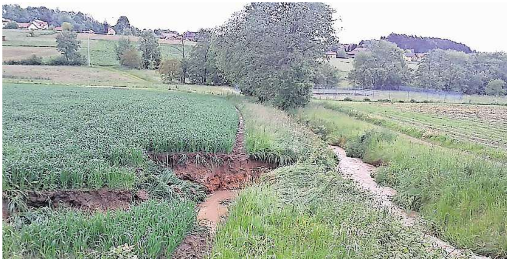
Im Mai 2013 gruben die Wassermassen des Grasenbachs infolge der starken Regenfälle ein neues Bachbett durch ein Feld.
