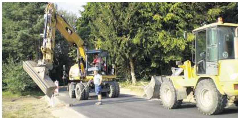
Anfang September befestigte die Firma Seebauer die Straßenpfosten entlang des Mühlweges, hier im Bereich der „Ettlweiher-Kurve“.
