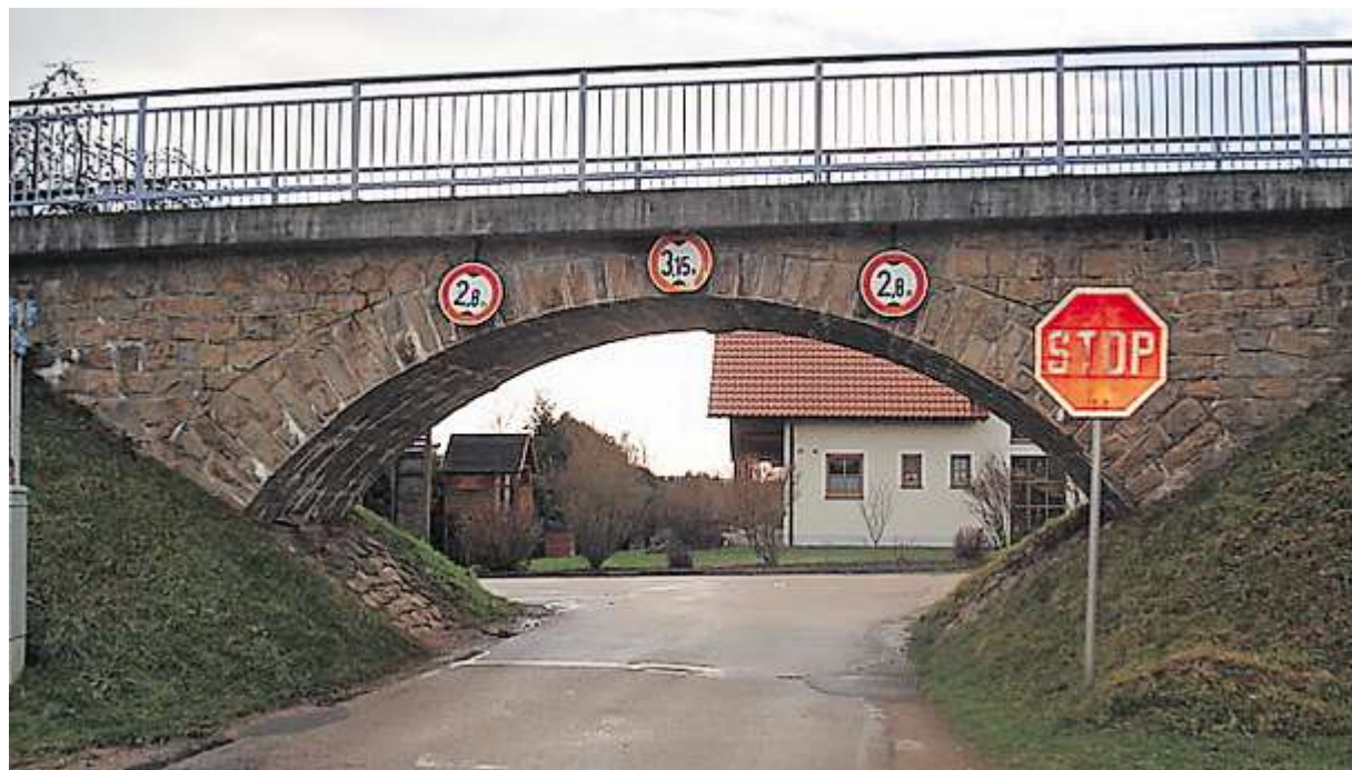
Die zu niedrige und enge alte Bahnbrücke in Erzhäuser, über die nun der Fahrradweg von Bodenwöhr nach Neunburg verläuft. Foto: tal
