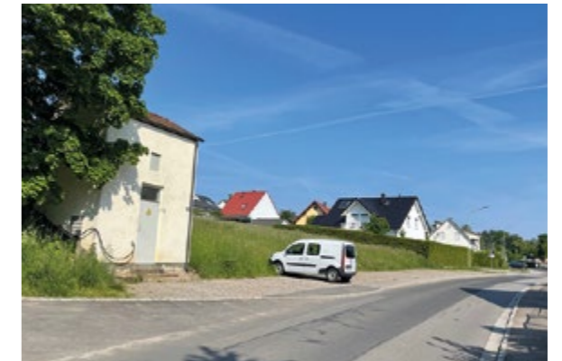
In der Ludwigsheide entsteht ein neues Baugebiet. Direkt unterhalb wird heuer ein neuer Parkplatz gebaut – vor allem für Badegäste. Fotos: R. Ahrens
