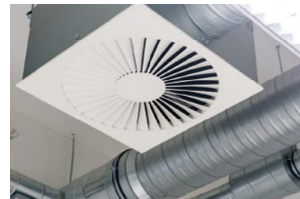
Die Pandemie macht den Einbau von Lüftungsanlagen erforderlich. Stockfoto©ti6781
