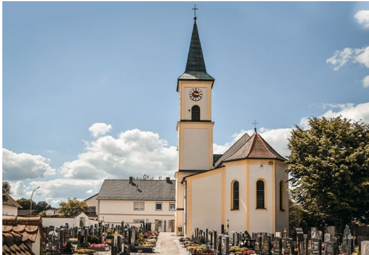
Die Kirche in Neuenschwand entstand bereits im 9. oder 10. Jahrhundert. Im 19. Jahrhundert wurde sie aufgrund der „Vermehrung der Seelenzahl“ vergrößert. Fotos: R. Ahrens
