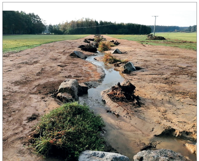
Der künftige Verlauf des Baches ist ersichtlich.
