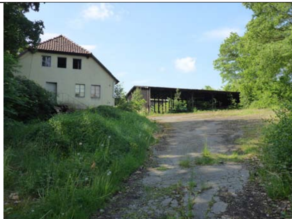
Foto 1: Bürogebäude und offene Lagerhalle
