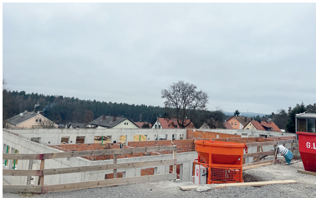
Die Schule nimmt bereits Formen an. Sie wird nach modernstem Standard gebaut.
