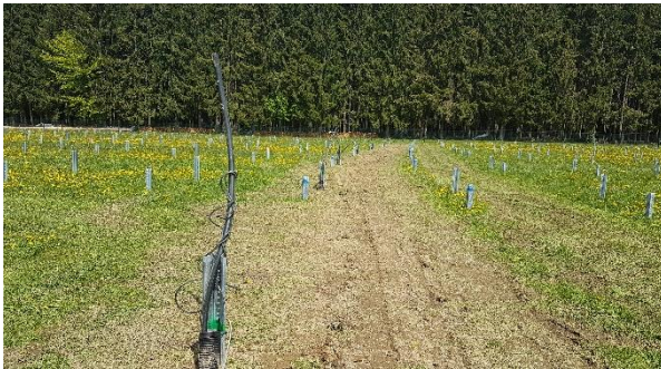
Abbildung 4: Verfüllter Kabelgraben
