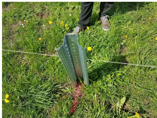
Abbildung 6: Rammfundament
