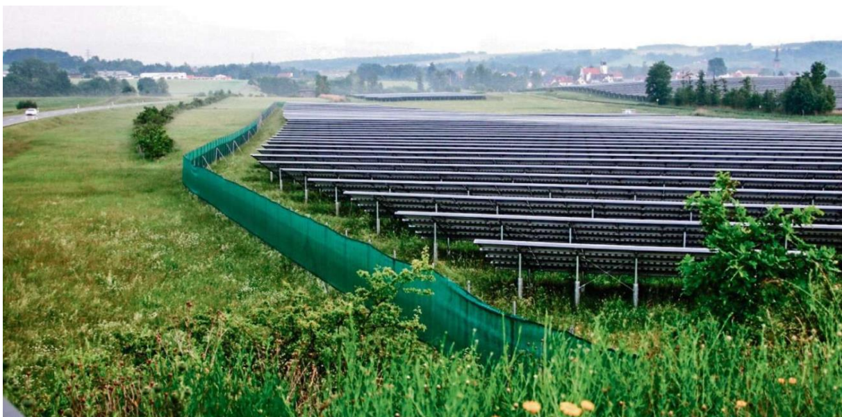
Abbildung 12: Beispiel Sichtschutzzaun Solarpark
