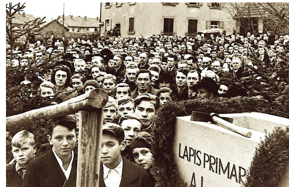
Zur Grundsteinlegung von St. Barbara kamen viele Gläubige.
