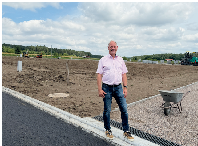
Mit Hochdruck wird am neuen Baugebiet gearbeitet. Bald können Parzellen gekauft werden, wie Bürgermeister Georg Hoffmann informiert.
